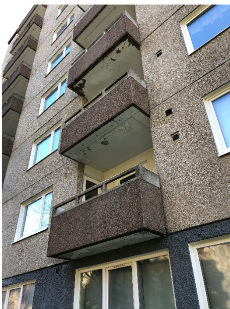
Figur 3. Balkonger på befintlig bebyggelse.
